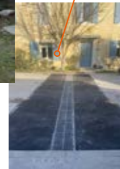
Écoulement eaux pluviales
